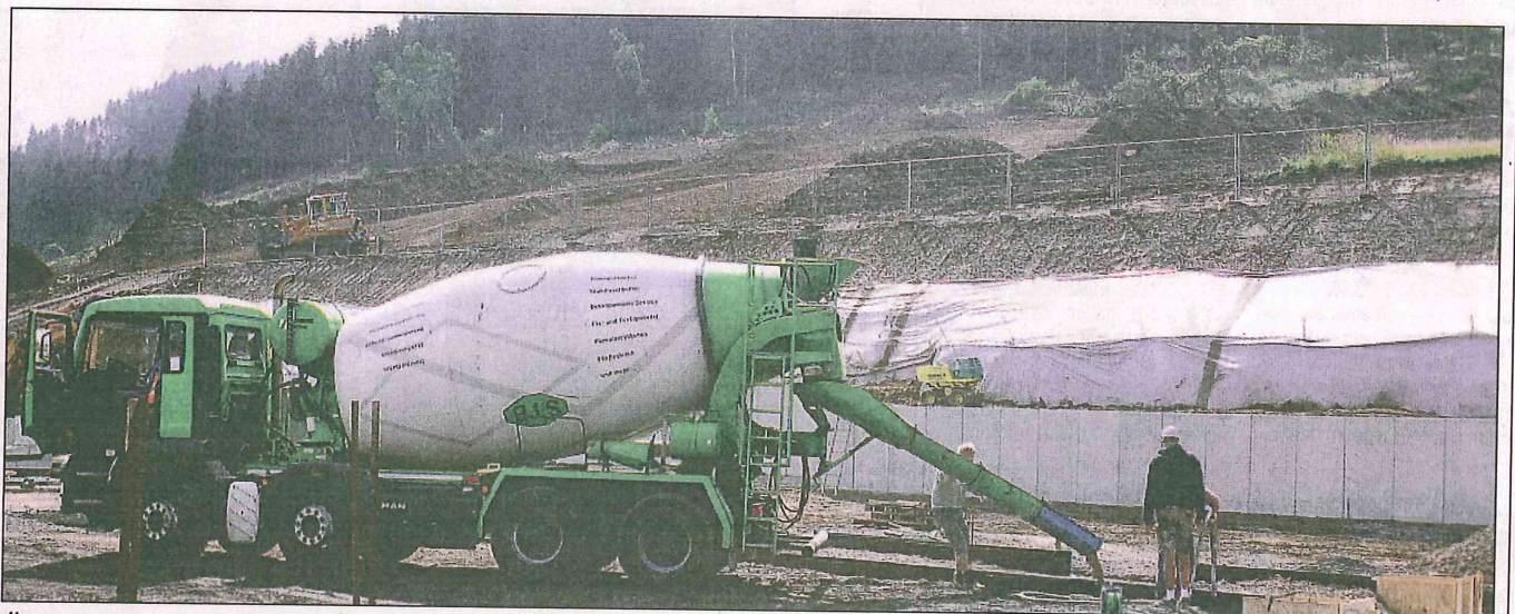
Über der Firmenhalle, für die gestern Fundamente betoniert wurden, wird ein 17 000 qm großer Eichenbestand angelegt.
