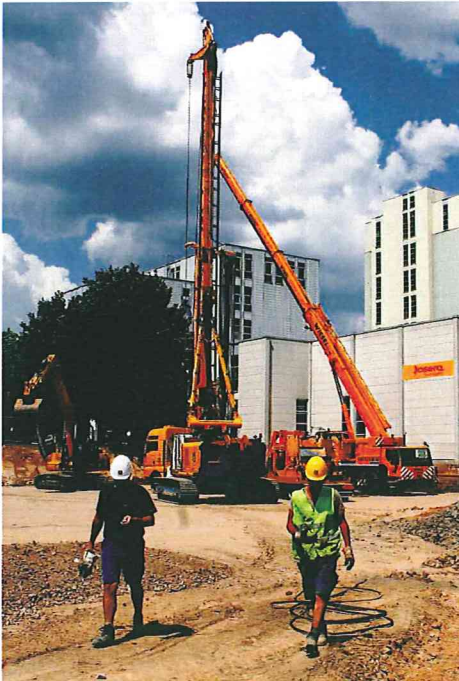
Hoch hinaus: Mit einem 30 Meter großen Hochregallager und weiteren Bauten will die Kleinheubacher Tierfutterfirma Josera ihre Produktion verdoppeln. Doch zunächst muss die 28 Meter hohe Maschine (Mitte) Löcher für die Fundamentsäulen bohren.
